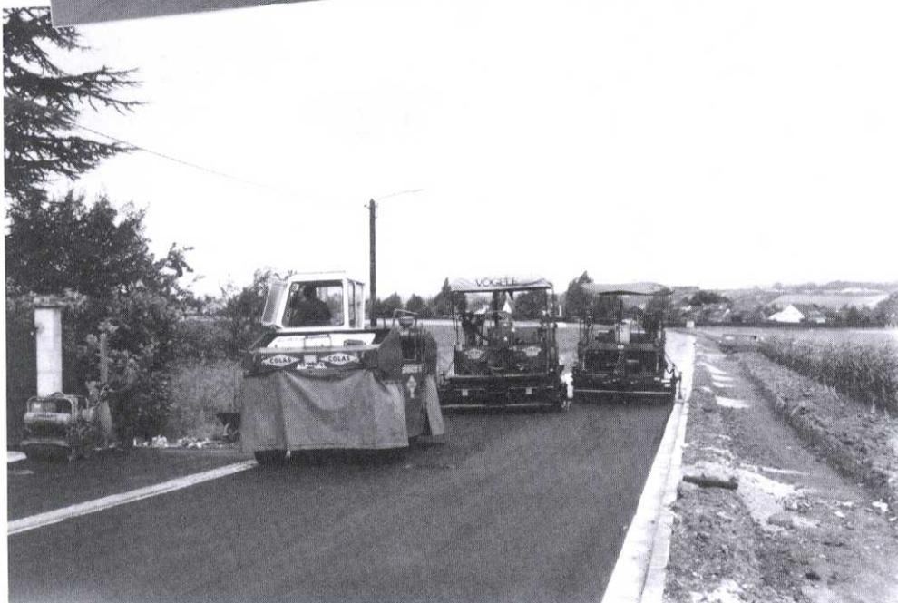
2- Pendant ce temps on prépare le chemin piétonnier et le canal hydraulique, en bordure de chaussée, sur une largeur de 5m.
