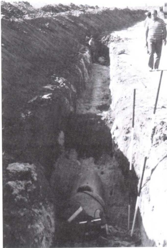
*L'ouvrage hydraulique de protection contre les inondations est constitué d'un réseau de canalisations enterrées vu à ciel ouvert en bordure du CV1 et du CV3 et d'un bassin d'orage (construit en 1989) placé près du chemin de la Butte. Les eaux sont déversées dans le Rû de Maldroit.*
